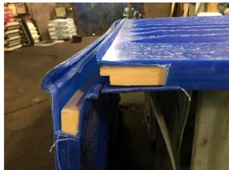
2. Выровнять панели по нижнему краю (ребро задней панели должно находиться под ребром боковой панели):
