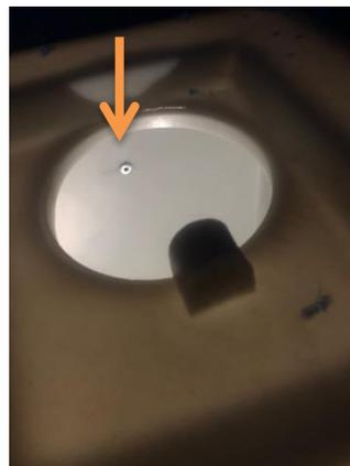
12. Установить крышу. Просверлить 15 отверстий в крыше и трех боковых панелях (по 5 отверстий на каждую сторону), ориентируясь на специальные ребра жесткости, и закрепить вытяжными заклепками. На лицевой панели закрепить 7 заклепками аналогичным способом.
